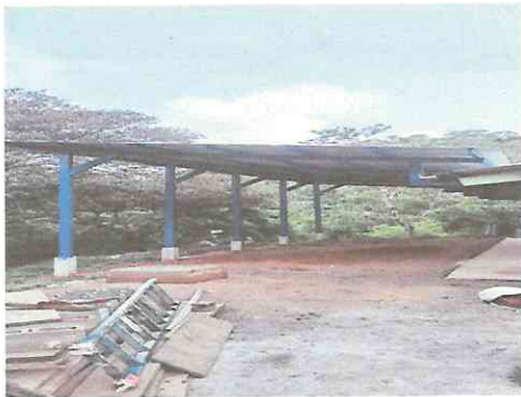
Foto 3: Finalización de construcción y ampliación de galera.
