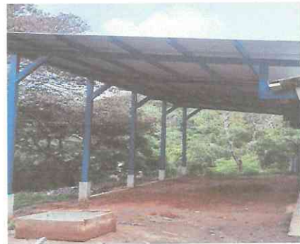
Foto 4: Finalización de construcción y ampliación de galera.
