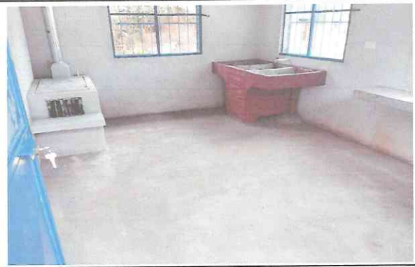
Foto 2: Finalización de construcción de cocina.
