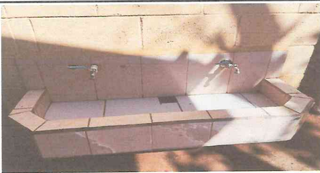
Foto 5: Finalización de instalación de tubería de agua entubada.
